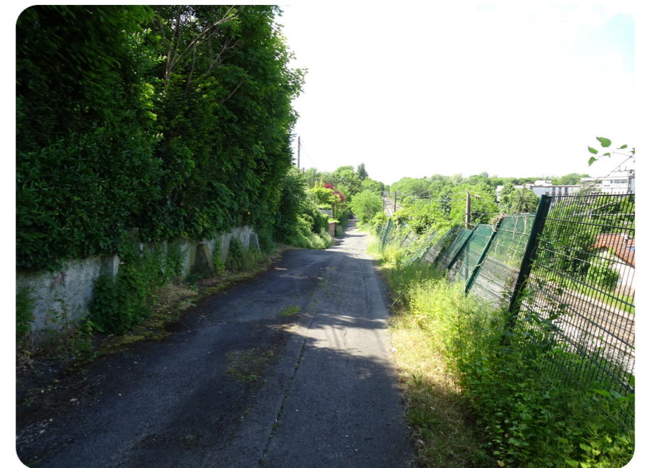
Dénivelé et revêtement dégradé sur le passage de l'Alma (source TRANS-FAIRE, 2022)
