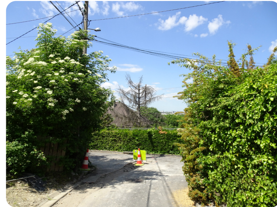
Revêtement en travaux sur la rue de Brétigny (source TRANS-FAIRE, 2022)
